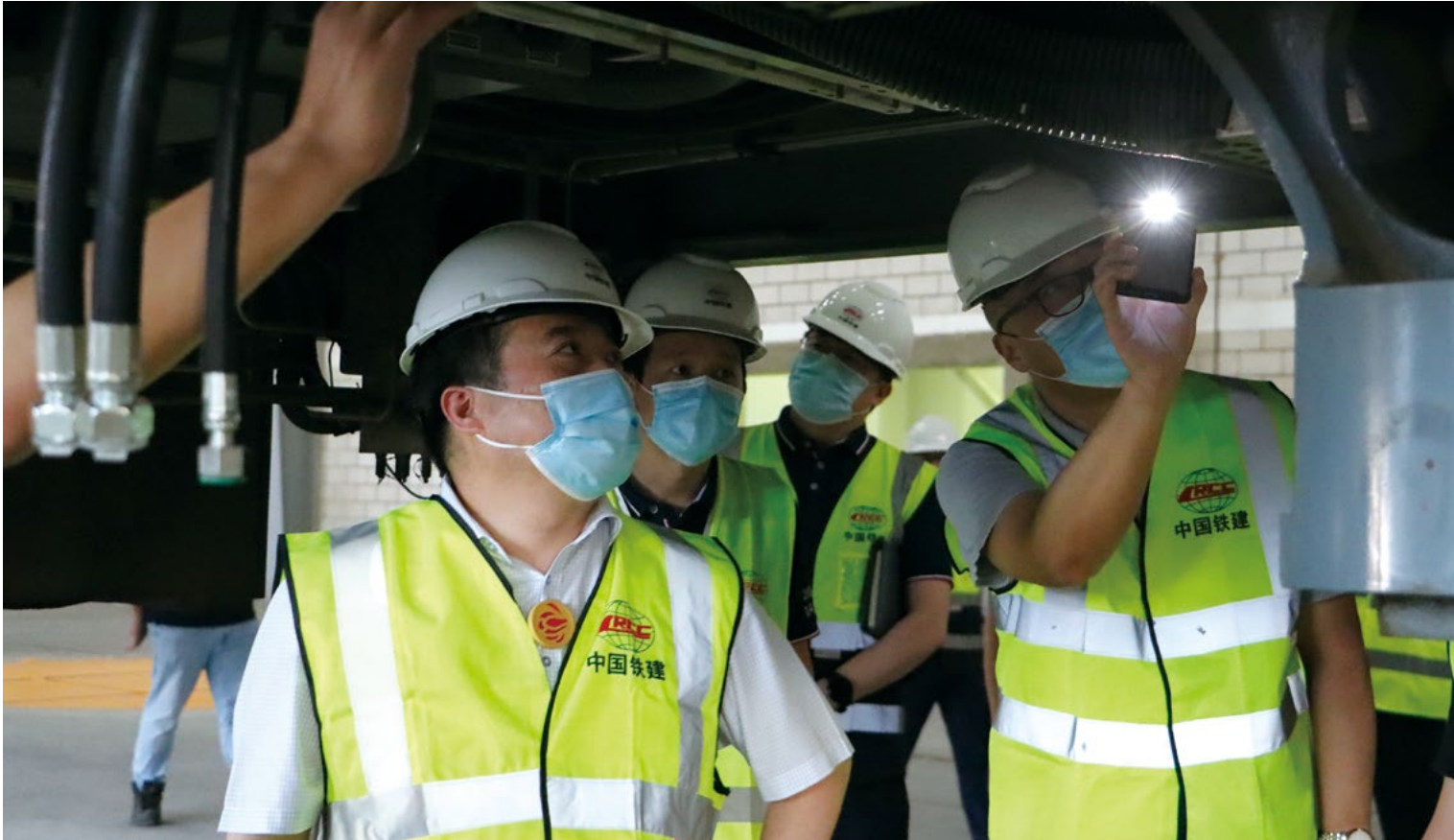
中国铁建检查列车重修库，逐一排查安全隐患
