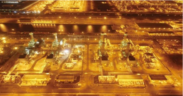
中国电建承建的吉赞 IGCC 联合循环电站为沙特提供电力保障
