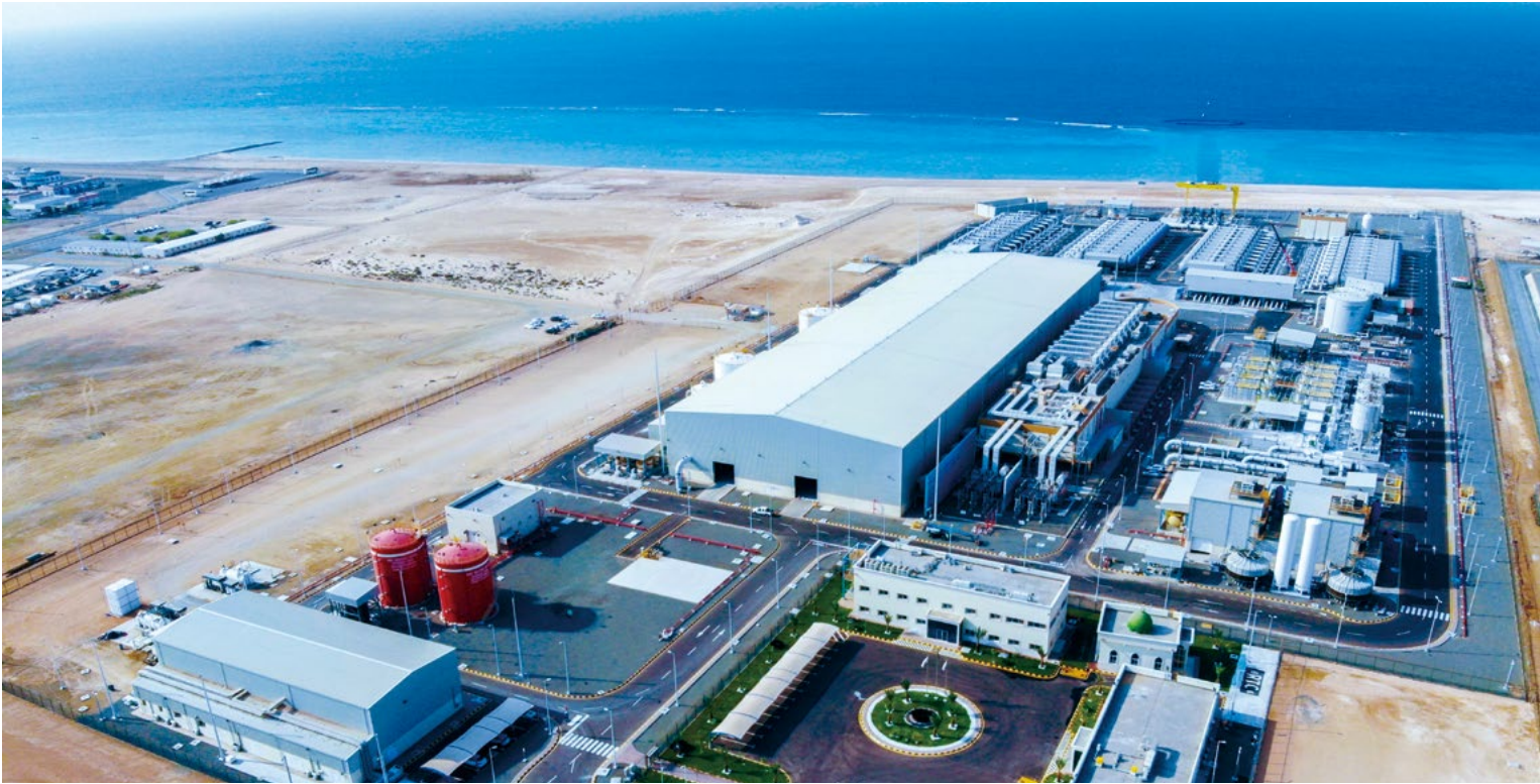
中国电建拉比格三期海水淡化项目
