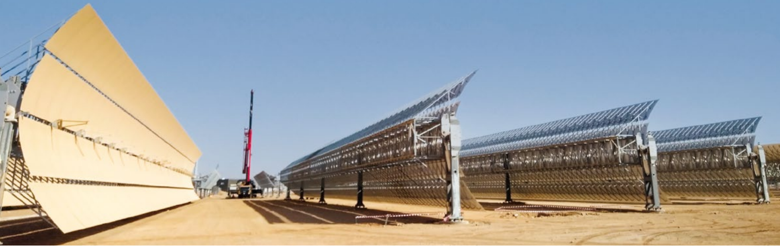
中石化炼化工程公司参与的沙特电力公司“绿色杜巴”综合太阳能联合循环发电厂项目
